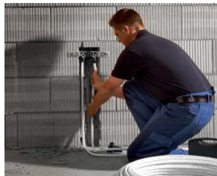
Вставить трубу в фитинг – соединение готово!
